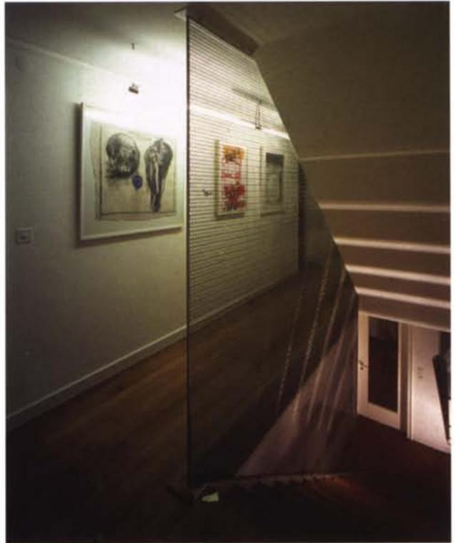
Das als seitliche Treppenbegrenzung montierte filigrane Gittergeflecht aus Stahl kommt normalerweise in der Lebensmittel-Produktion als Transport-Band zum Einsatz.
