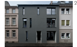
2 Bonn: Passivhaussanierung © Foto: DGJ
